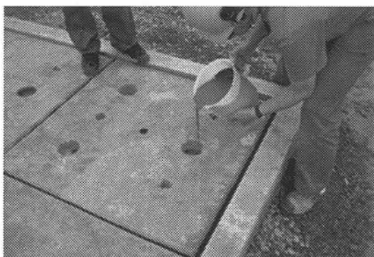
(写真-7) 空孔部の充填
