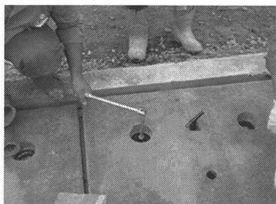
(写真-5) アンカーボルトの締付け
